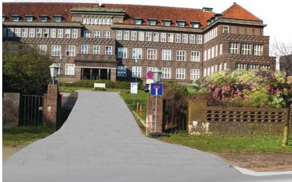
Blick in die Zukunft: An der Wildeshauser Straße soll neben der jetzigen Klinik, dem Höger-Bau (links), ein kompletter Neubau entstehen. Der Umzug ist für 2026 geplant.
